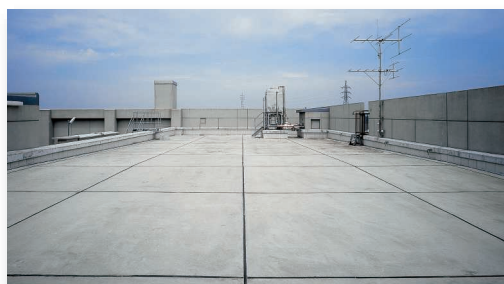
アスファルト防水保護コンクリート仕上げ
