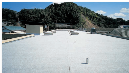
アスファルト防水露出砂付き仕上げ
