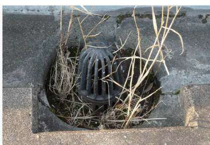
ドレン(排水口)部土砂の堆積・ 植物の生育 (植物の根はコンクリートも貫通します。)
