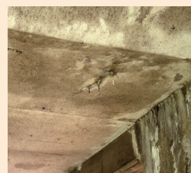
ベランダ上げ裏部の雨漏りによるコンクリート成分のしみ出し（エフロレッセンス）
