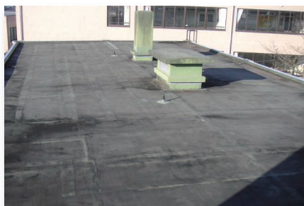
保護塗料の退色 (トップコートの塗り替えが有効です。)
