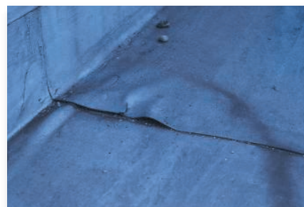
シートの破断・損傷
