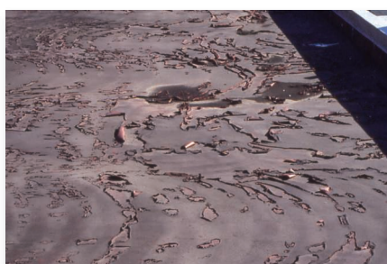
塗膜防水層の劣化
