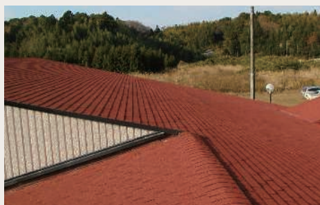
「勾配屋根用シングル防水システム」 によるかぶせ改修
