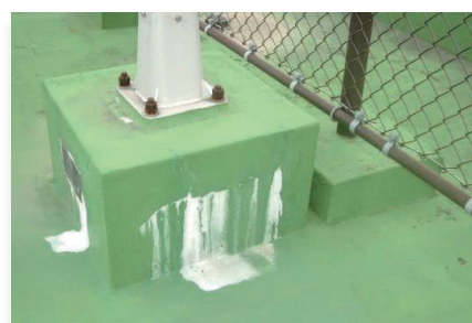
防水の裏側に雨水浸入・塗膜防水破断 コンクリート成分の染み出し
