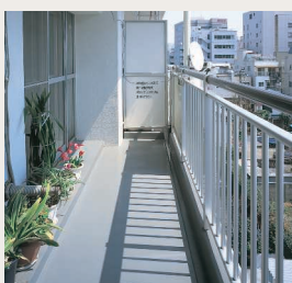
ウレタン塗膜防水ベランダ工法 オルタックエース
